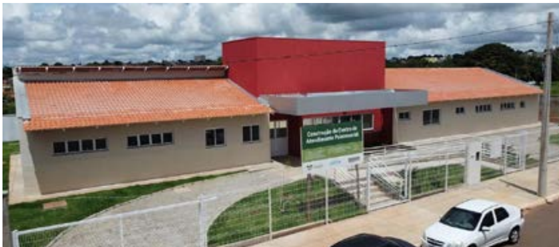
Obras do novo Caps se aproximam do fim
